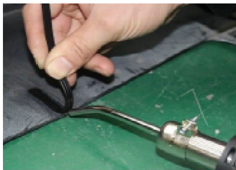
Svaření poškozeného místa.
